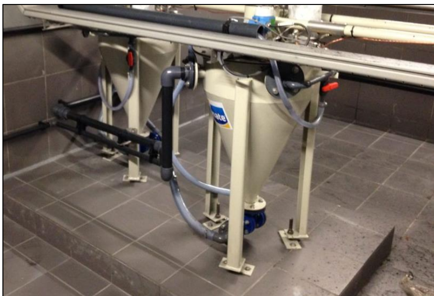
Figure 39 : exemple d'implantation d'un système d'injection de CAP pour le traitement de l'eau (source: sodimate.fr).
