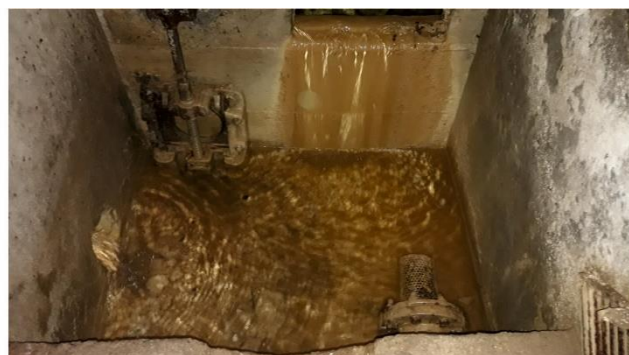
Arrivée d'eau et crépine de captage
