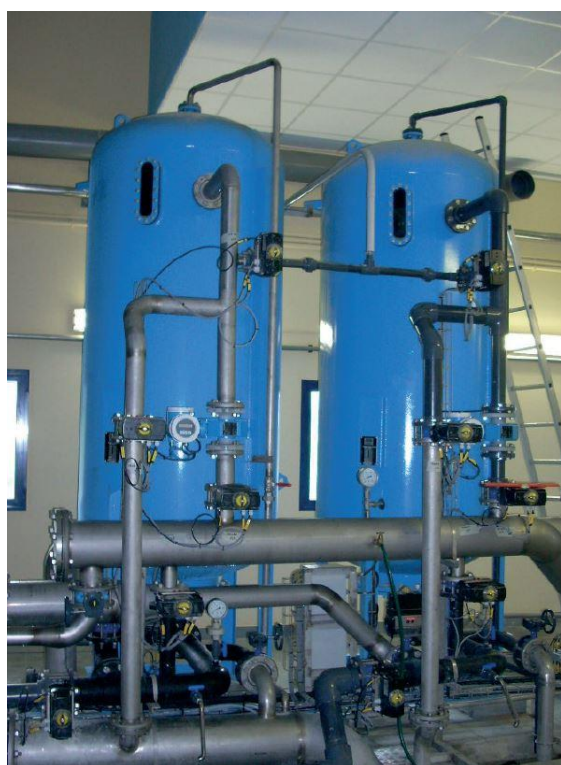
Figure 34 : exemple d'une installation de traitement par échange d'ions et schéma de principe (source: SUEZ).
