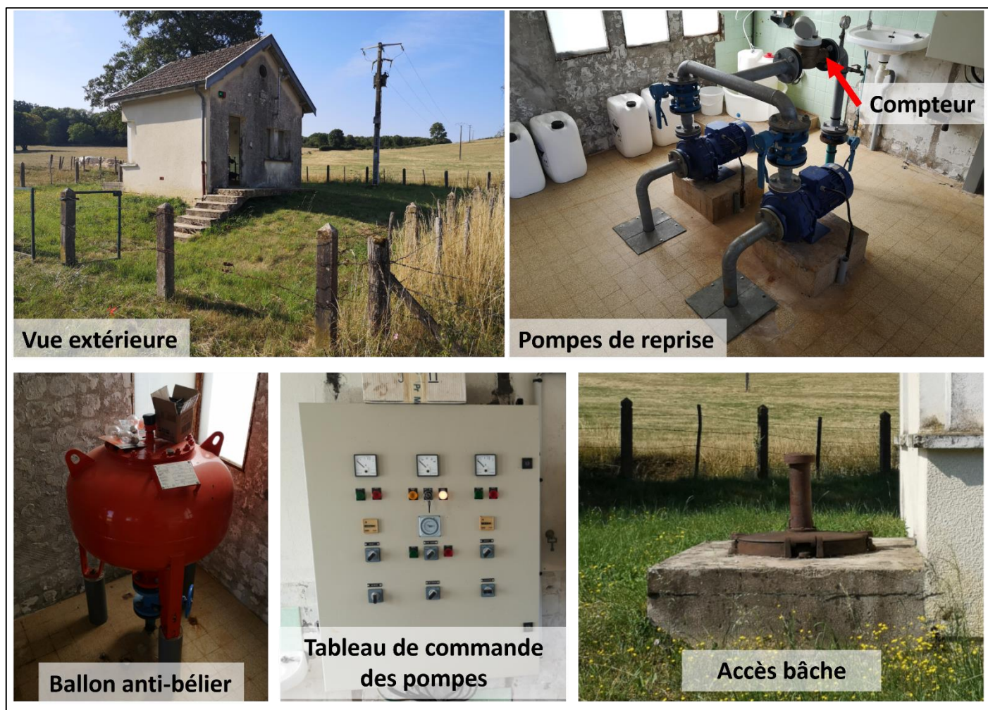
Figure 20 : planche photo de la station de relevage de Montigny (source : Sciences Environnement)
